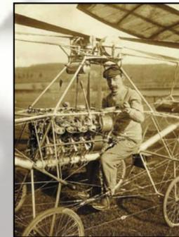
constitué par quatre rotors biplans quadripales (32 pales en tout) de 7 m de diamètre pesant plus d'une demi-tonne. L'appareil, trop lourd pour se maintenir en l'air, se soulève brièvement à
