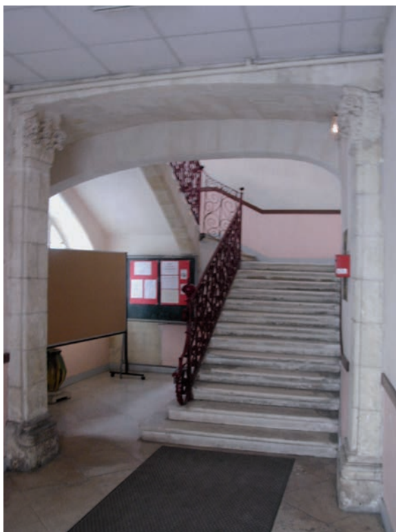
ill. 17 : Vue du grand escalier, édifié vers 1700.
