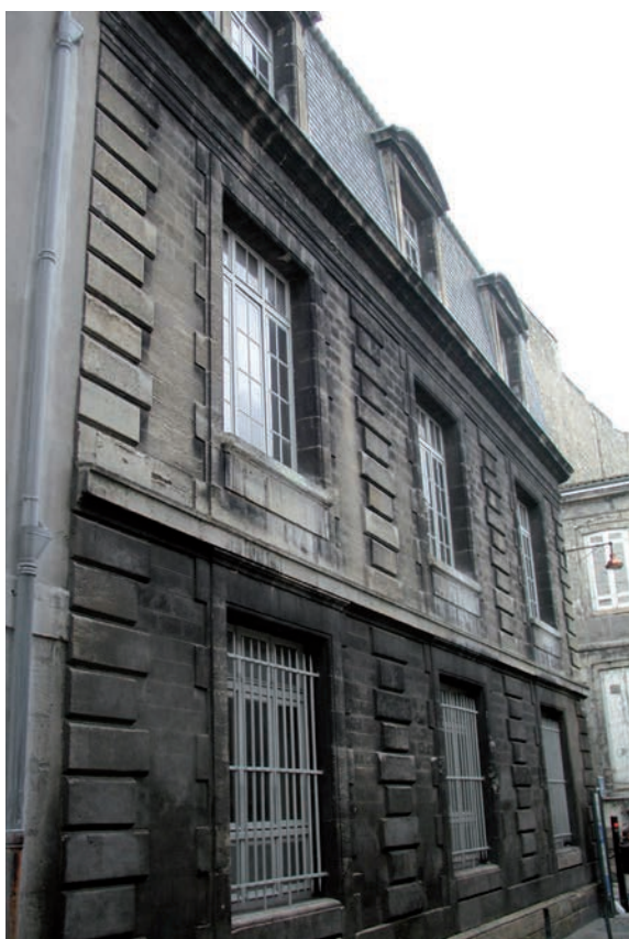
ill. 29 : Façade rue Guiraude.
