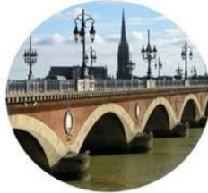
Pont de pierre à Bordeaux
