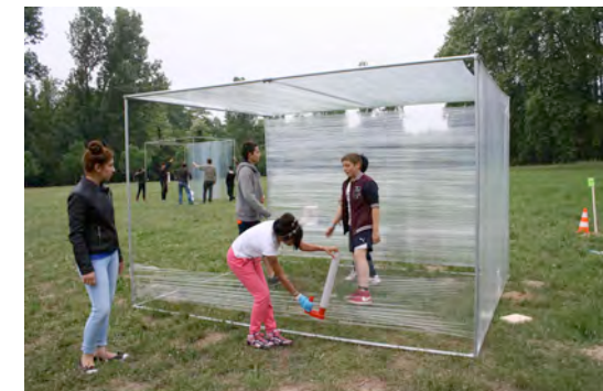
ATELIER STRUCTURE MÉTALLIQUE Enroulement de l'enveloppe en film translucide
