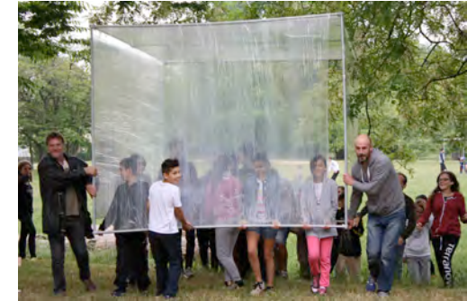
TRANSPORT DES STRUCTURES POUR ASSEMBLAGE DU REFUGE
