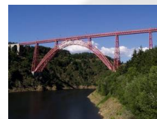
Le Viaduc de Garabit
