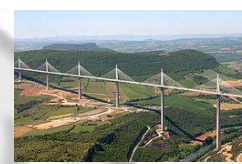
Le Viaduc de Millau
