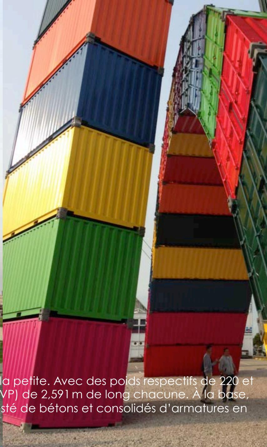
En tout 36 conteneurs: 21 pour la grande arche, 15 pour la petite. Avec des poids respectifs de 220 et 32 tonnes de boîtes métalliques équivalent vingt pieds (EVP) de 2,591 m de long chacune. À la base, le conteneur de 2,5 tonnes pourra atteindre 20 tonnes, lesté de bétons et consolidés d'armatures en ferraille à chaque porte.
